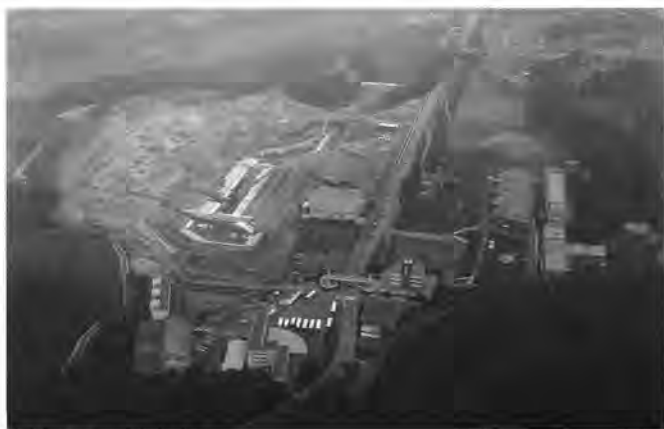
東松山校舎・第一期工事
