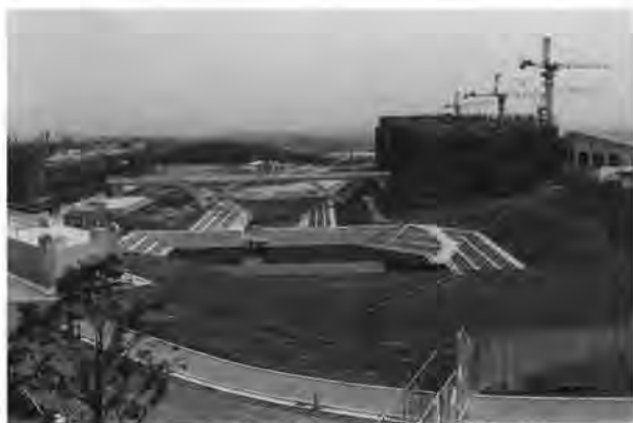
東松山校舎建設中の調整池と記念講堂(昭和59年頃)
