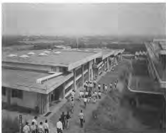
東松山校舎1号館(右)・階段教室(左)
