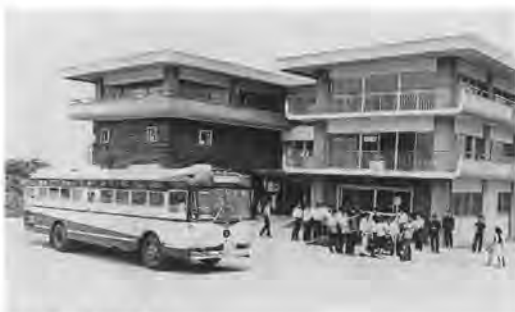
東松山校舎旧厚生棟
