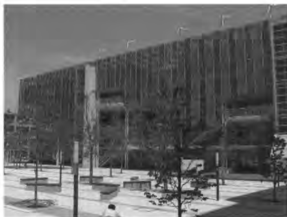
板橋校舎3号館
