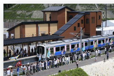
仙石線の復旧(野蒜駅)
